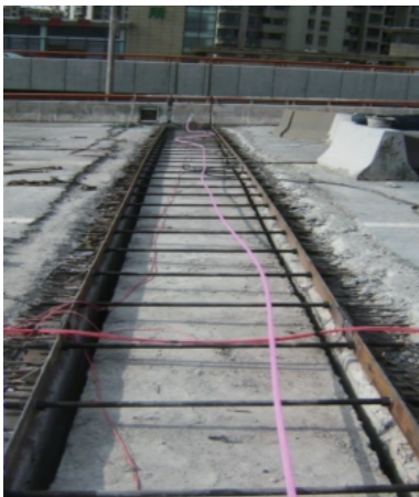
图3 纵向位移控制装置
