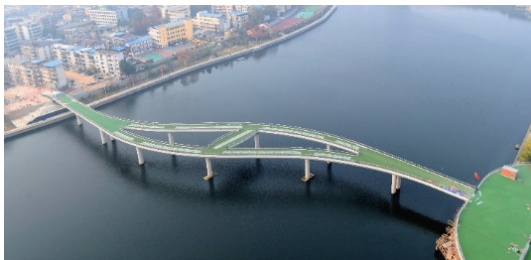
图 1 东洲人行桥全貌
