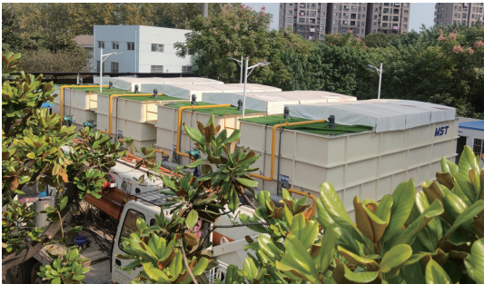
图 4 气浮装置安装完成整体效果
