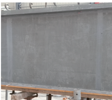
图 8 使用木模板的试件表面
