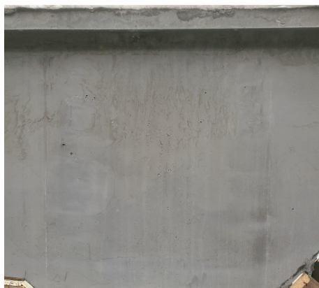
图 6 使用钢模板的试件表面(模板干燥)
