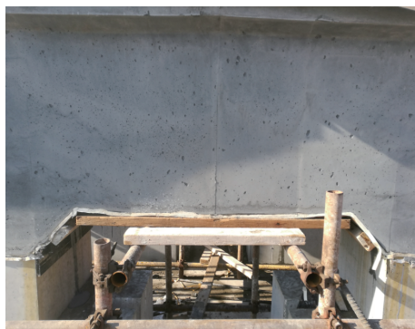
图 7 使用钢模板的试件表面(模板沾水)
