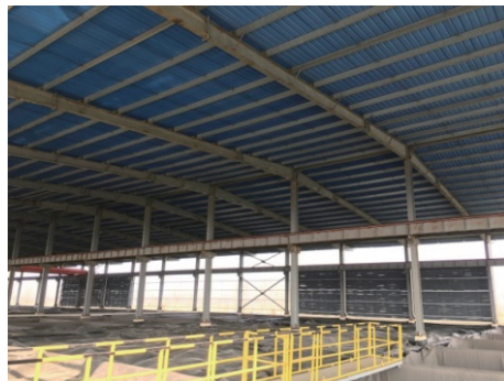
图 5 人工辅助作业栈桥
