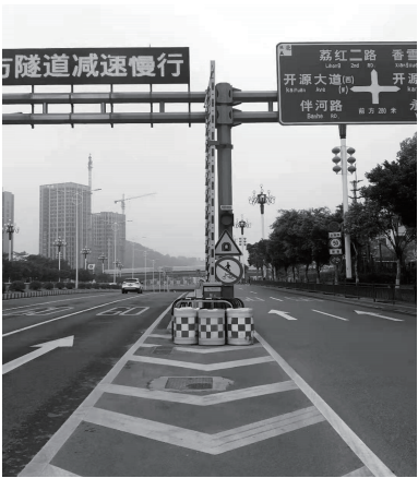
图 6 隧道道闸设置示例图
