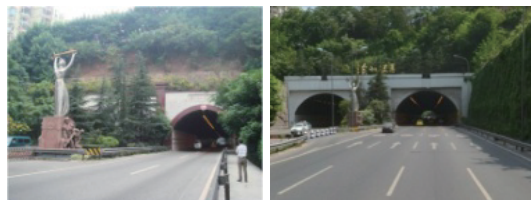
(a)改造前 (b)改造后 图 18 渝州隧道进出口改造前后对比图
