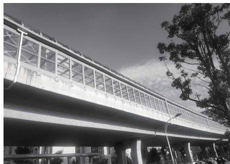
图6 全封闭声屏障桥梁外置式排水
