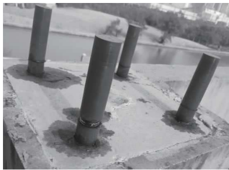
图8 预埋螺栓防腐保护
