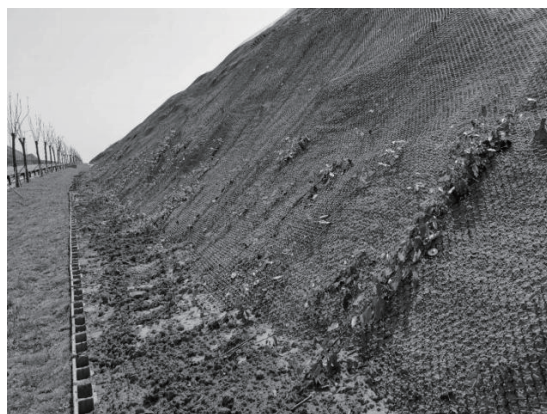
图2 喷浆坡面安装
