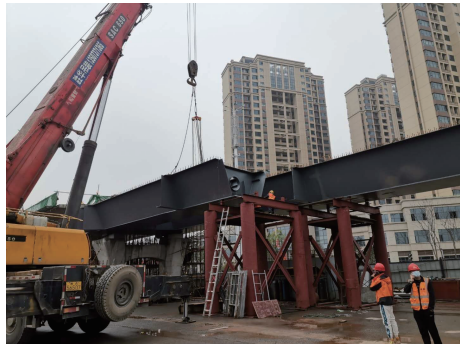
图9 钢结构主梁现场吊装
