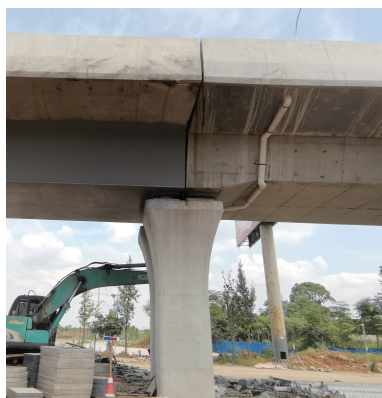
图6 混凝土梁变高段处理-实景图
