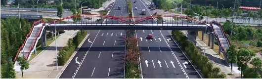
图10 人行天桥建成实景
