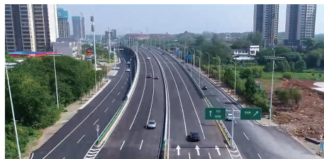
图2 玉龙路主线上跨桥建成实景
