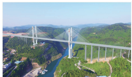
图 2 乌江特大桥实景图 [5]
