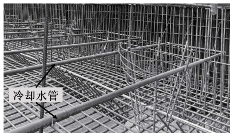
图6 水闸底板冷却水管布置图
