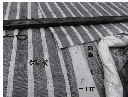
图8 水闸底板保温情况
