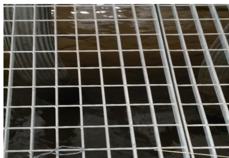
图 6 膜清洗气洗结束工况图
