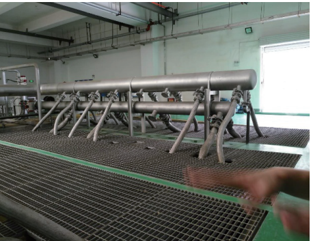
图 4 膜组件上部管道连接
