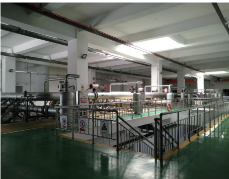
图 3 膜池车间现场
