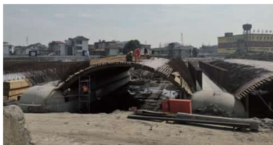
图9 拱架施工
