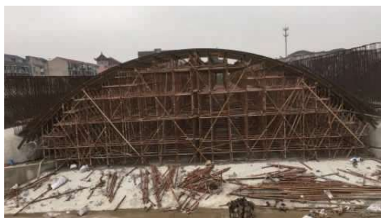
图8 满堂支架施工
