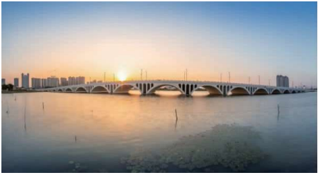
图 5 成桥立面实景图
