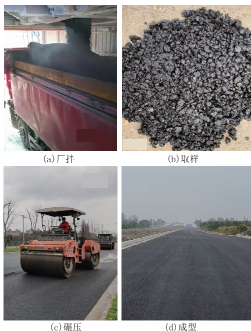
图4 直投型高黏改性剂厂拌施工过程
