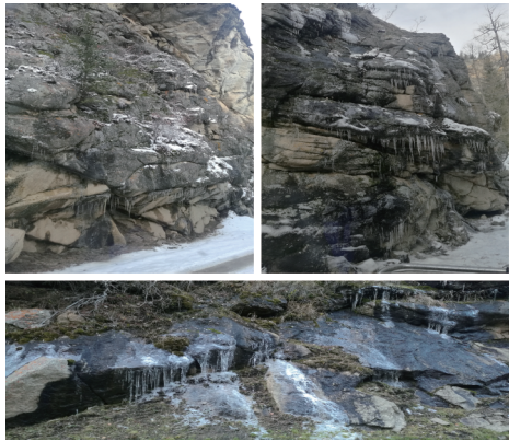
图 1 坡面裂隙涎流冰
