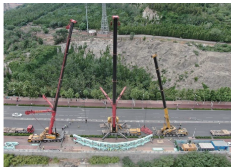
图 10 现场吊装照片
