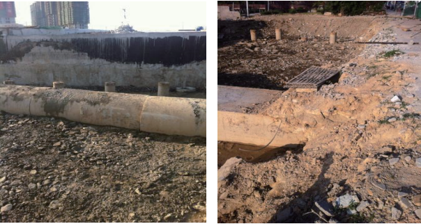
(a)现场情况一 (b)现场情况二
