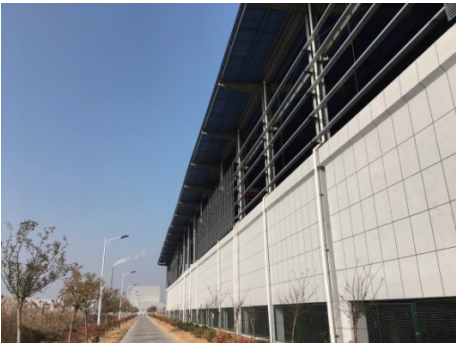
图 8 固定雨棚及挡雨板图
