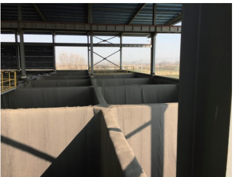
图 7 填埋单元防渗图
