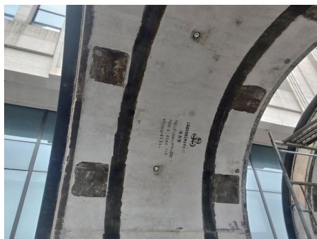
图6 管节连接件及注浆孔预埋照片
