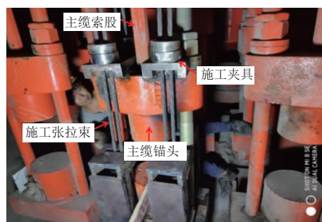
图 4 现场拉杆更换图
