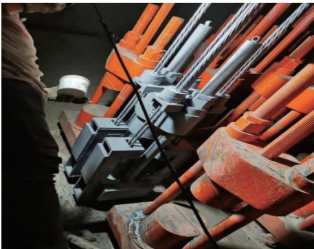
图 8 拉杆中间漆防腐涂装
