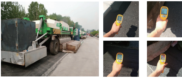
图3 就地热再生加热作业
