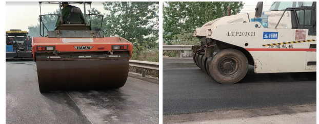
图6 就地热再生压实作业
