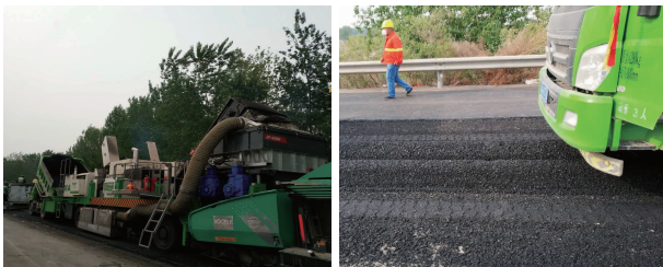
图4 就地热再生耙松、拌合作业
