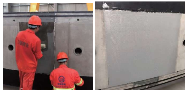
图 10 接缝外防水体系创新
