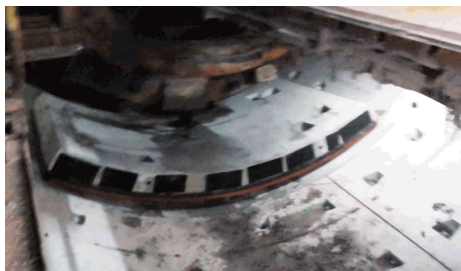
图3 装好金属网电极的管片安装之图示
