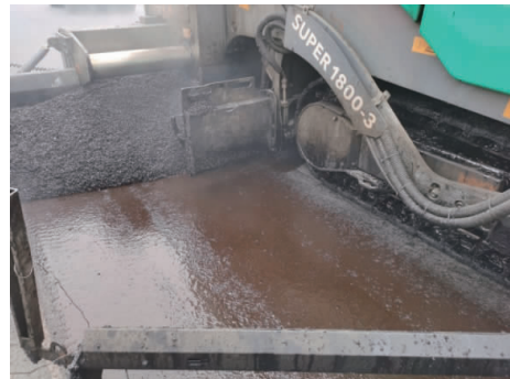
图4 同步摊铺机现场实施图
