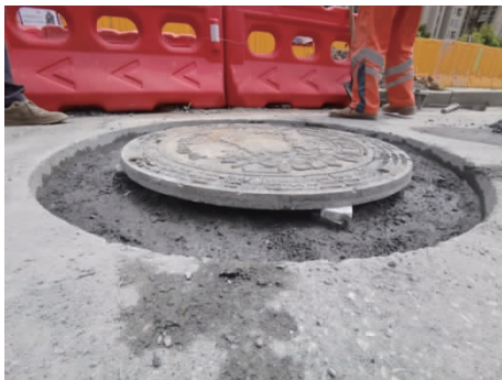
图1 确定井盖抬升高度
