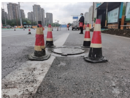
图2 回填井盖边槽
