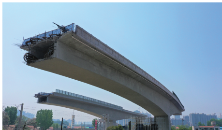
图 9 济水大道跨新兖铁路桥转体桥施工
