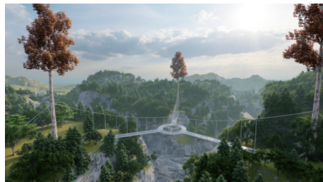
图3 鸡鸣三省大峡谷三岔形人行悬索桥
