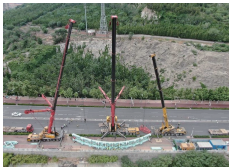
图 10 现场吊装照片
