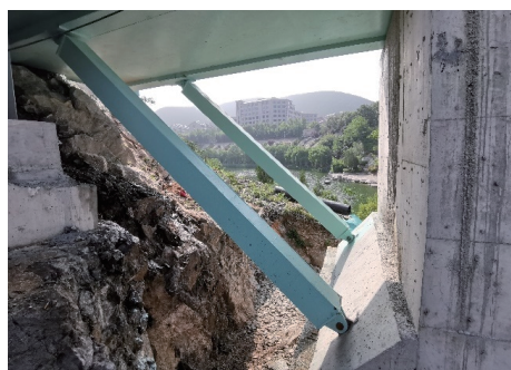
图 5 边跨斜撑杆照片
