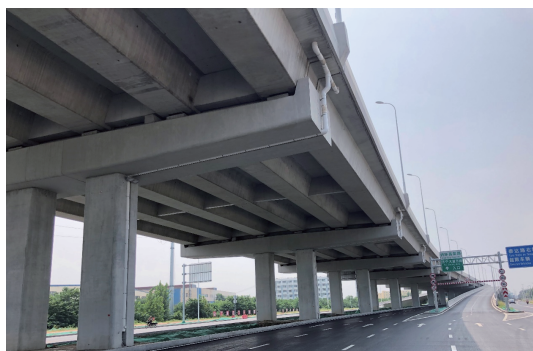
图4 主线高架建成实景图
