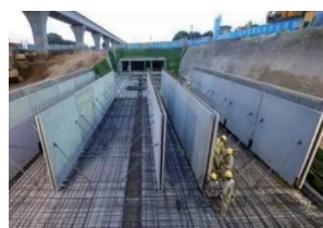
(c) 叠合板预制拼装综合管廊
