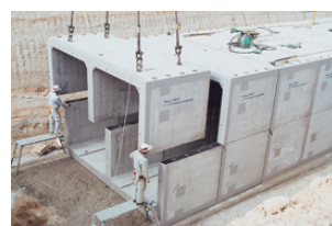
(b) 分块节段预制拼装综合管廊
