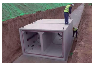
(a) 整节段预制拼装综合管廊
