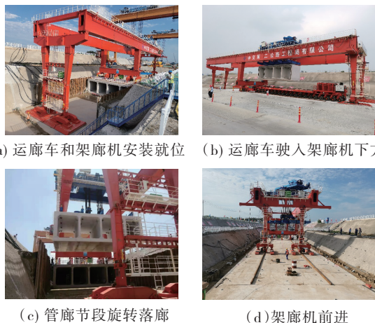
图 4 综合管廊运廊车和架廊机施工流程
