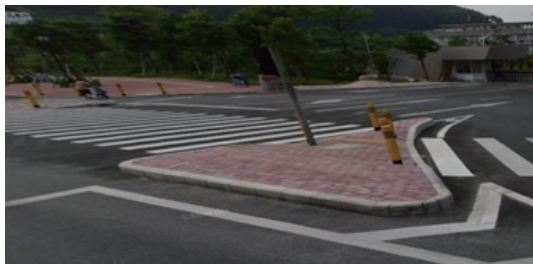
图 5 渠化岛面积小于 20 \text{ m}^2
