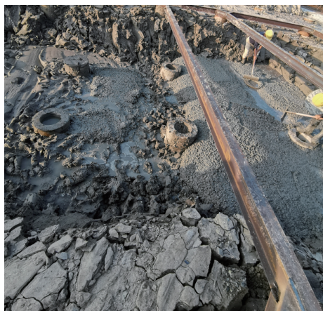
图8 及时浇筑垫层做封底支撑之实景
