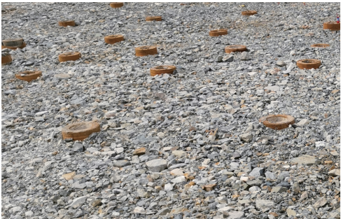
图 2 塘渣嵌固桩基效果之实景
