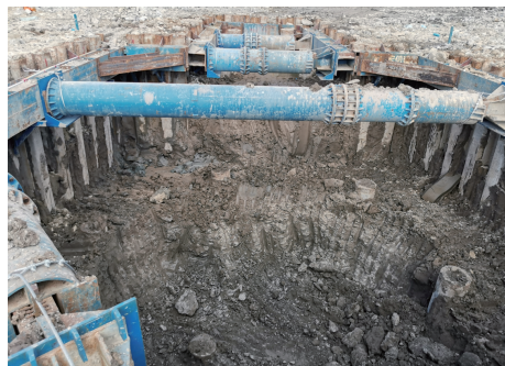
图11 加固后土方开挖效果之实景
