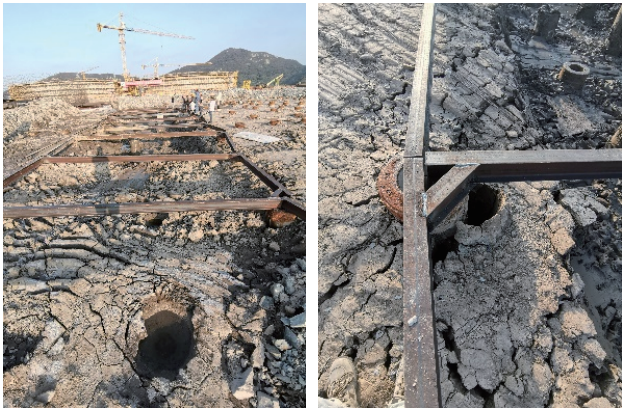
图 7 局部落深处工字钢加固及土方开挖后桩未偏位,土体断层之实景
