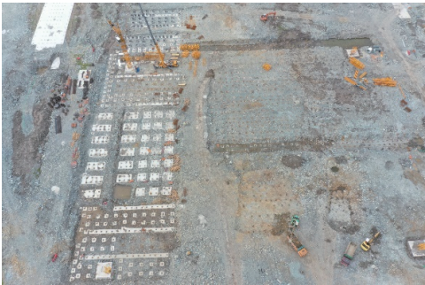
图 1 塘渣回填区域整体开挖效果之实景
