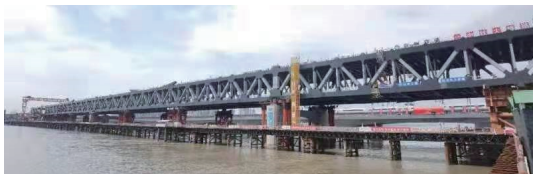
图 11 顶推合龙后的钱塘江大桥
