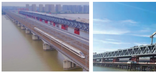
(a) 支架组拼钢桁梁
