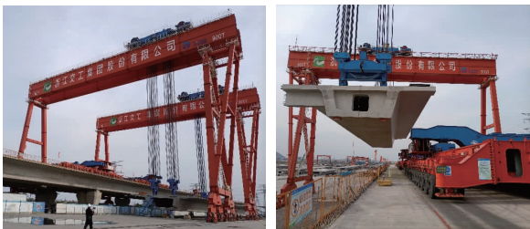
图4 双机900 t提梁机整孔预制箱梁吊装作业
