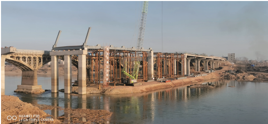
图 10 主桁架现场支墩拼装图
