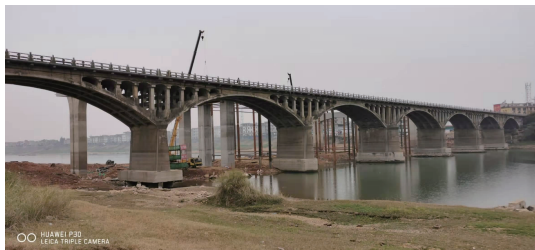
图 1 现状老桥照片
