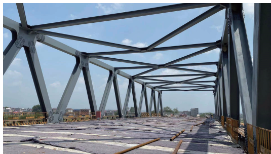
图7 上平联米字形横撑照片
