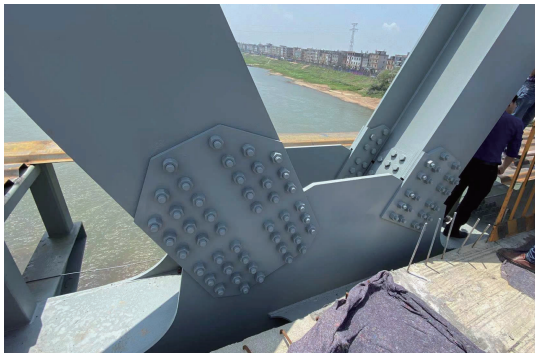
图 6 主桥腹杆照片
