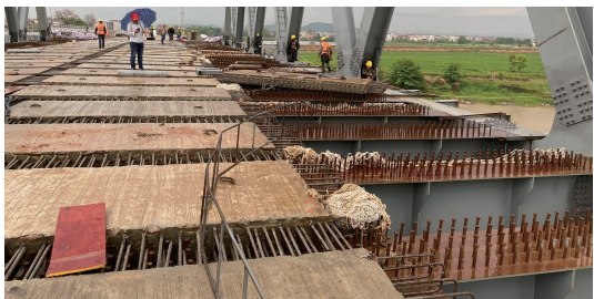
图8 主桥桥面系照片
