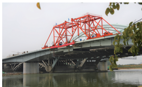
图7 济宁大道跨京杭运河桥吊装施工
