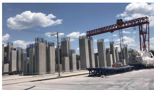
图2 桥墩盖梁预制场
