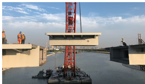
图8 济水大道跨京杭大运河桥吊装施工
