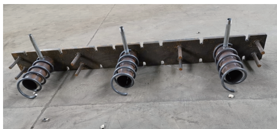
图5 新型圆锚锚具之实景(一)
