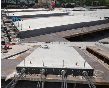
图10 1#-3#预制板梁现场实景
