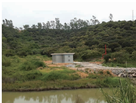
图4 高压燃气管道阀室之实景
