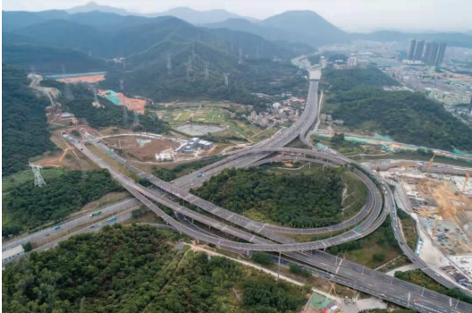
图 13 锦龙立交建成后之实景
