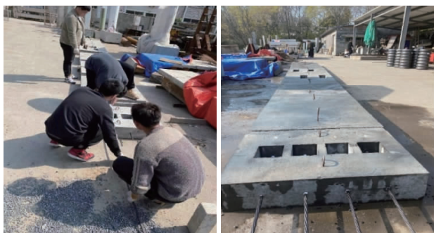
(a) 预应力钢绞线穿入 (b) 路面板拼装完成 图 6 装配式路面施工工艺
