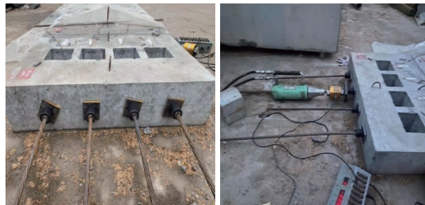
(a) 钢绞线的锚固 (b) 钢绞线张拉 图 7 张拉预应力钢绞线
