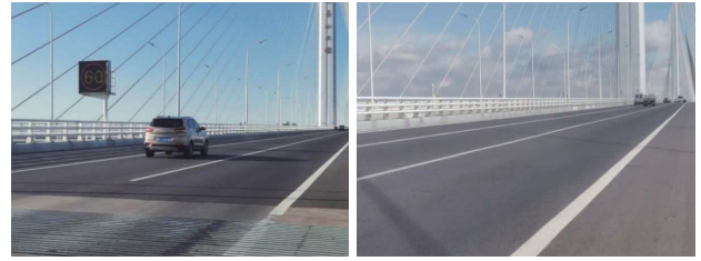
图6 2020年底钢桥面铺装情况
