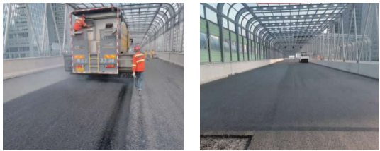
图 8 防水黏结层与透水沥青混凝土施工
