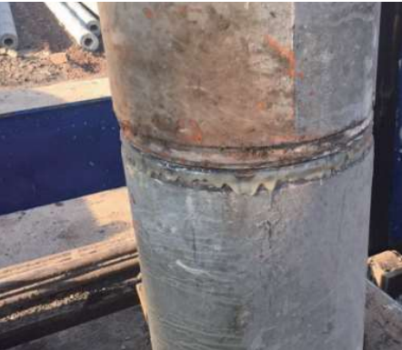
图 6 接桩密封胶使用方式
