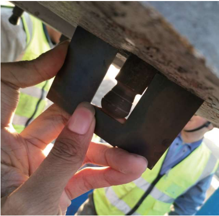
图 5 插杆安装方式
