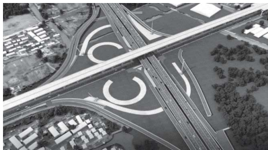
图7 方案一第1阶段——拆除立交的示意图
