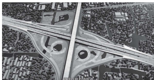
图10 拆除4根右转匝道
