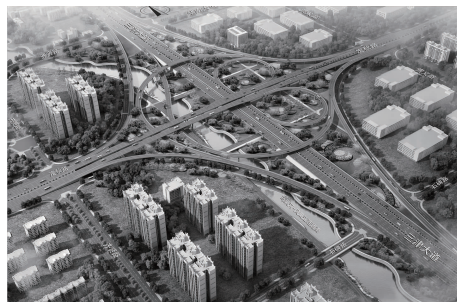
图3 方案二:半苜蓿叶半定向组合式三层全互通式立交效果图
