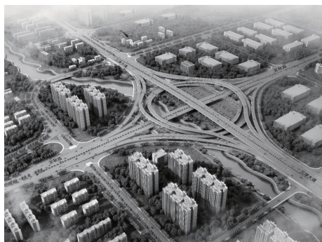
图2 方案一:涡轮式三层全互通立交效果图
