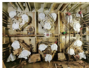
(a)通道内壳体情况
