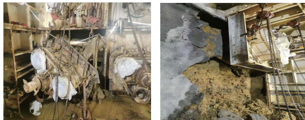
(b)顶管机弃壳拆解
