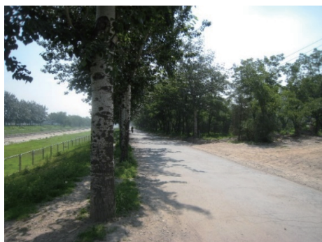
图3 改造前的永引南路
