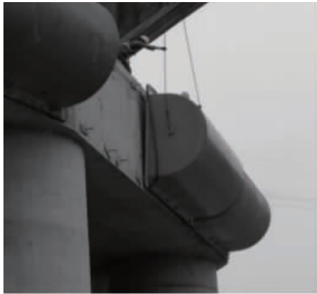
图 13 D型橡胶固定护舷示意图
