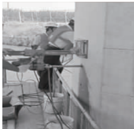
图 12 钻孔植筋示意图
