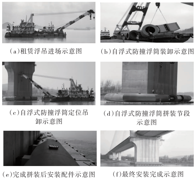
图 10 自浮式浮筒安装示意图
