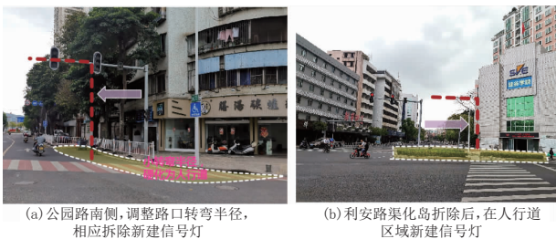
(a)公园路南侧,调整路口转弯半径,相应拆除新建信号灯 (b)利安路渠化岛拆除后,在人行道区域新建信号灯
