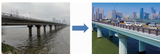
(b)桥梁涂装改造前后对比
