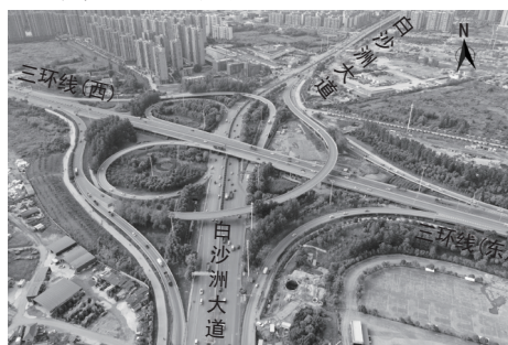
图11 现状青菱立交航拍图
