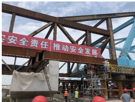
图 9 拖拉施工现场 2
