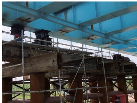
图 8 拖拉施工现场 1
