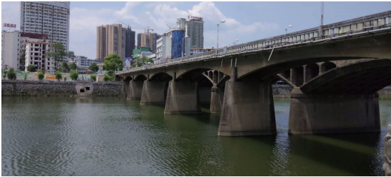
图 10 现状跨秀江老桥照片
